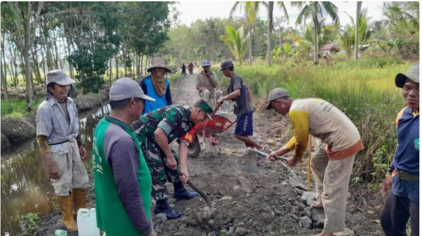
Bersama warga Binaan Babinsa Koramil 1005-10/Tamban Perbaiki Jalan Menuju Perkebunan
